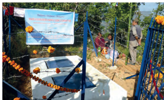
Source sécurisée de l'eau du puits pour usage commun et irrigation
